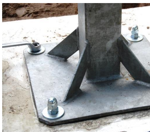
Stap 21 Draai de meegeleverde dopmoeren over de draadeinden. Draai allen stevig vast en zie er op toe dat de voetplaat waterpas staat. Gebruik hiervoor sleutel 24mm.
