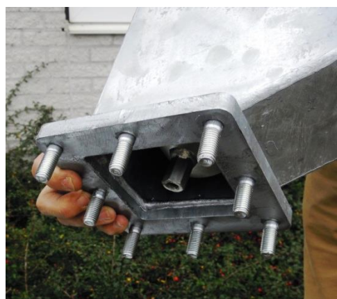
Stap 23 Laat iemand de pompkop optillen tot boven de rvs-stang van de pompbuis.
