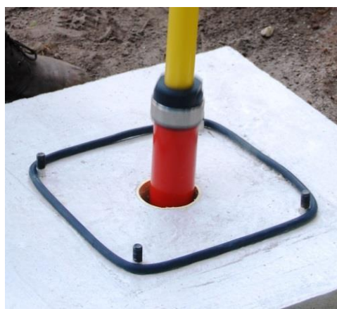
Stap 13 Laat als eerste de rode pompcilinder in de bron zakken en houdt de gele pompbuis goed vast voorkomt dat deze in de bron valt.
