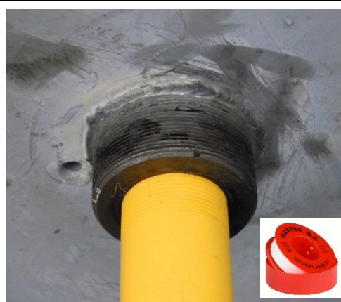
Stap 19 De bovenste pompbuis (zonder draadsok) kan nu in de onderzijde van de pompvoet gedraaid worden. Gebruik PTFE tape voor 100% afdichting van de draadverbinding.
