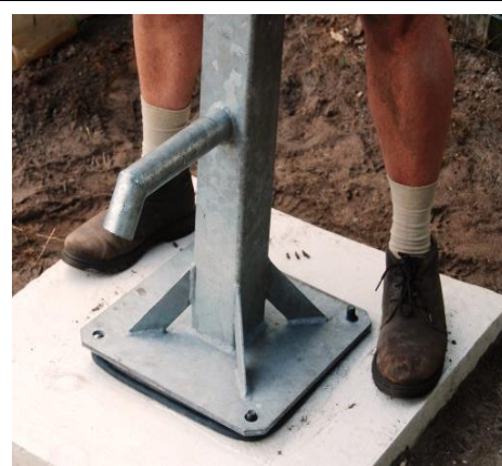
Stap 20 Plaats de voet op de rubbering, over de draadeinden. Let op de juiste/gewenste richting van de wateruitloop.
