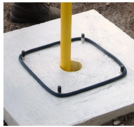
Stap 14 Laat de gele buis langzaam in de bron zakken. Houdt stevig vast.
