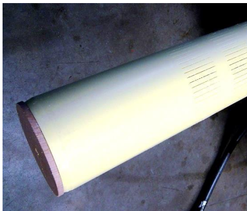
Stap 2 Grondboorder plaatst PVC-bronfilter. De minimale diameter van de filter voor deze versie SWN80 is 63mm.
