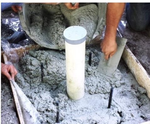
Stap 4 Nadat een eenvoudige bekisting is aangebracht kan het beton gestort worden. Een dikte van 20cm volstaat.
