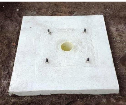
Stap 7 Kort de bronfilter af, gelijk aan de rand van het beton.
