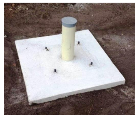
Stap 6 Verwijder bekisting.
