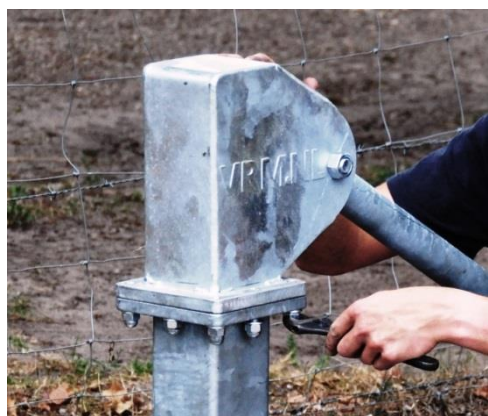
Stap 22 Plaats kop en borg met dopmoeren. Gebruik hiervoor sleutel 19mm.
