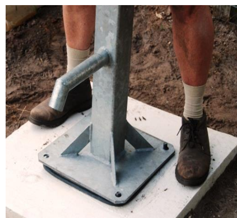
Stap 20 Plaats de voet op de rubberring, over de draadeinden. Let op de juiste/gewenste richting van de wateruitloop.
