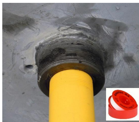
Stap 19 De bovenste pompbuis (zonder draadsok) kan nu in de onderzijde van de pompvoet gedraaid worden. Gebruik PTFE tape voor 100% afdichting van de draadverbinding.
