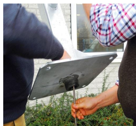
Stap 17 Laat iemand de pompvoet over de stang heen tillen terwijl de ander de stang stevig vasthoudt. Voer de stang volledig door de pompvoet.
